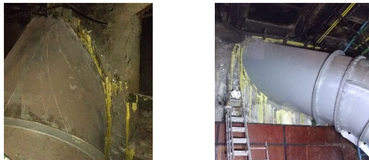
Рисунок 2 – Місця вводу напірних трубопроводів після ін'єкційної гідроізоляції
