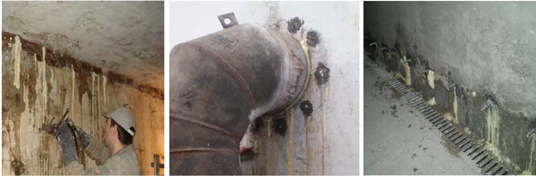
Рис. 8. Вихід піни з порожнин бетону після ін'єктування
