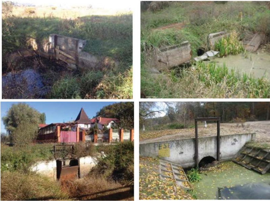
Рис. 4. Стан водорегулювальних гідротехнічних споруд на каналах Ірпінської ОЗС (2018 р., фото А.М. Шевченка)
