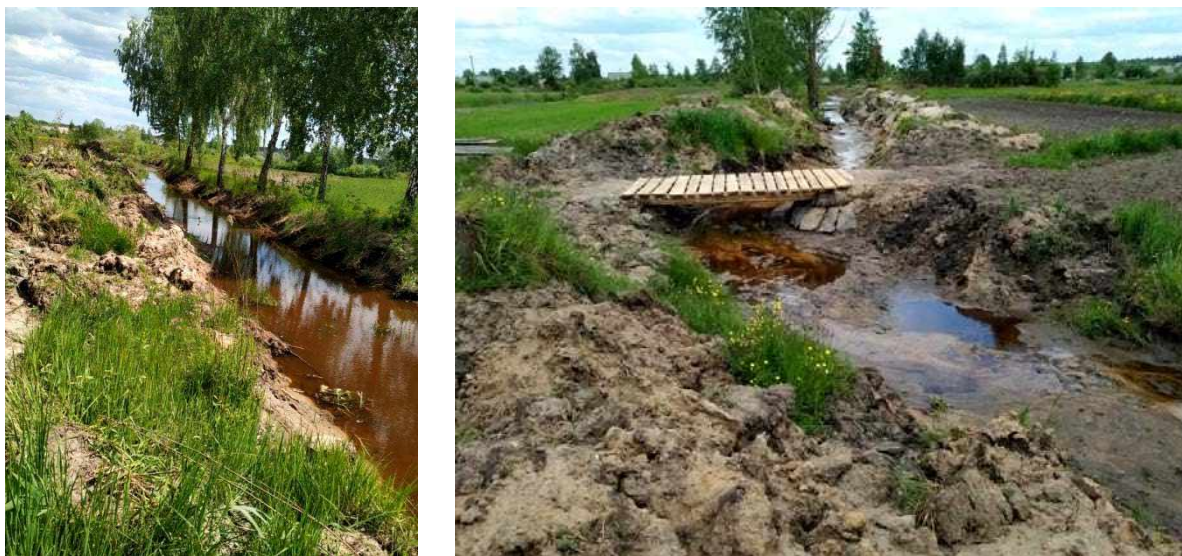
Рис. 3. Розчистка та днопоглиблення русла р. Вирівка з влаштуванням захисної дамби
