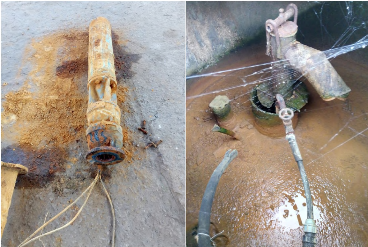
Рис. 2. Ремонт глибинного насоса на Кам'янка-Дніпровській експлуатаційній ділянці (ліворуч), ерліфтна свердловина № 155 (праворуч)
