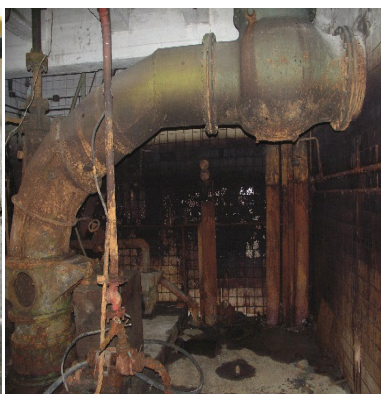
Рис. 2. Докова частина польдерної насосної станції в Закарпатській області
