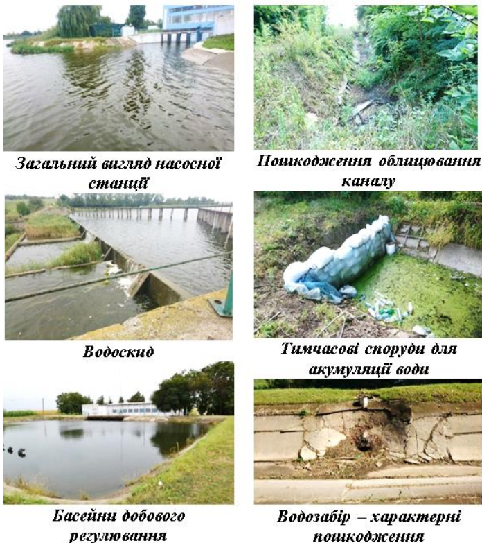
Рис. 2. Стан та загальний вигляд окремих ділянок НДЗС
