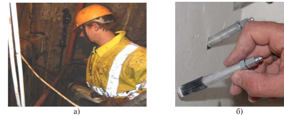
Рис. 6. Вибурювання ін'єкційних отворів (а) та встановлення пакерів (б)
