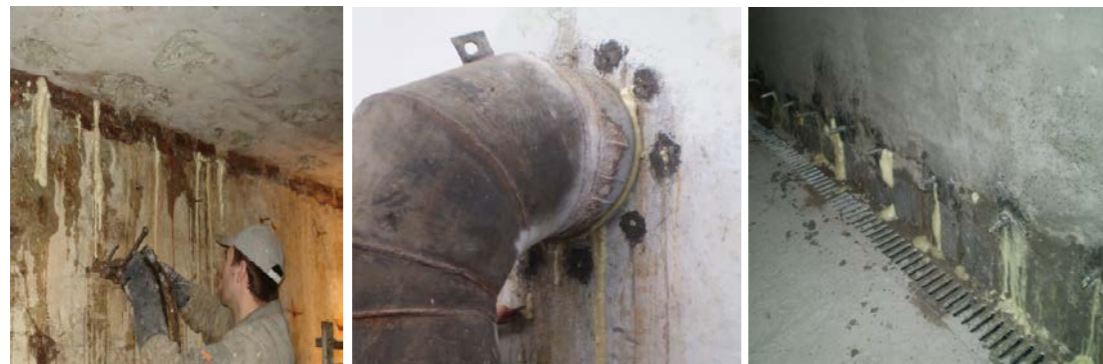
Рис. 8. Вихід піни з порожнин бетону після ін'єктування
