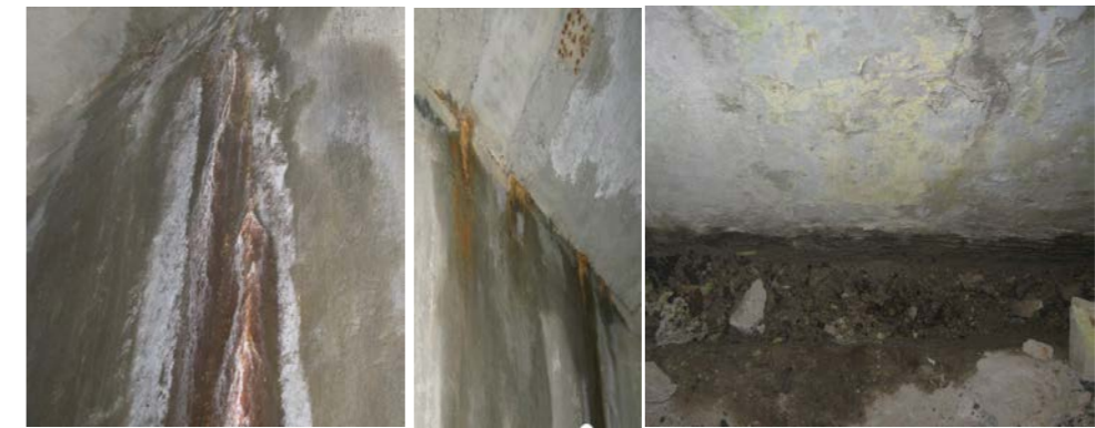
Рис. 1. Фільтрація води в докових частинах насосних станцій
